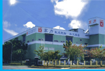
Kaohsiung Tayvan Tesisleri
